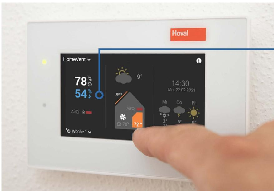
Die richtige Raumluftfeuchte zwischen 40 und 60 % hemmt die Verbreitung der Viren und die Austrocknung der Atemwege. Eine kontrollierte Wohnraumlüftung mit Feuchterückgewinnung, wie Hoval HomeVent®, stellt automatisch die optimale Luftfeuchtigkeit in bewohnten Räumlichkeiten sicher.
